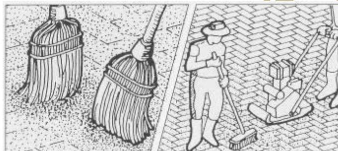
A areia é posta sobre os blocos de concreto numa fina camada (insuficiente para cobri-los totalmente) e espalhada com uma vassoura até preencher completamente as juntas. A varrição pode ser alternada (desde que se disponha do pessoal suficiente) com a compactação final.
